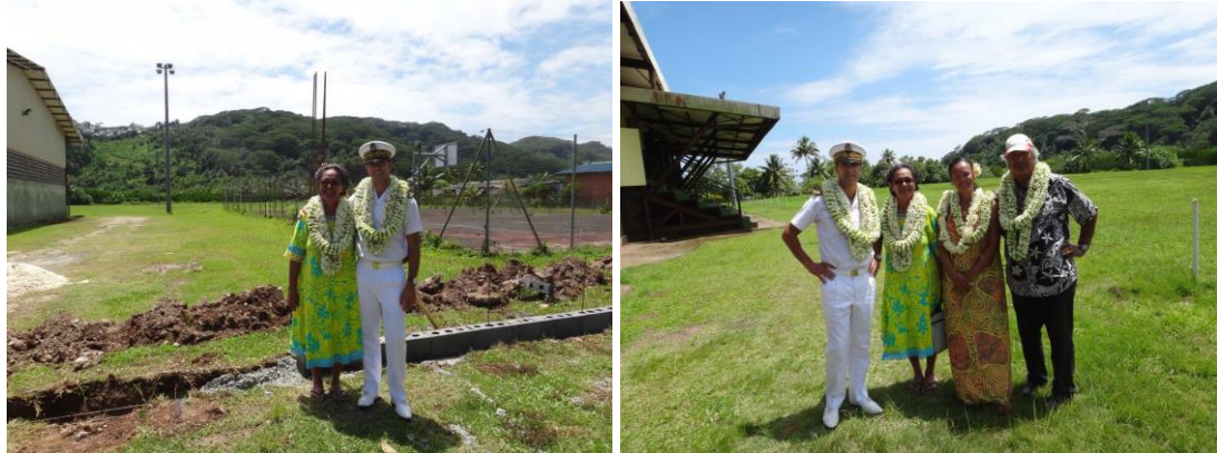
Visite du chantier du complexe sportif Jean Tupu
